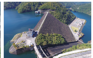
▲Rock-fill dam (Kuzuryu Dam)
