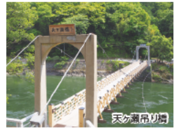
天ヶ瀬吊り橋
