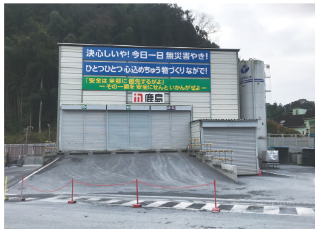
バッチャープラント
