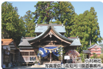
小村神社 写真提供：高知河川国道事務所
