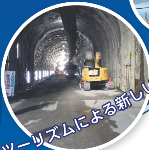
日下川新規放水路
