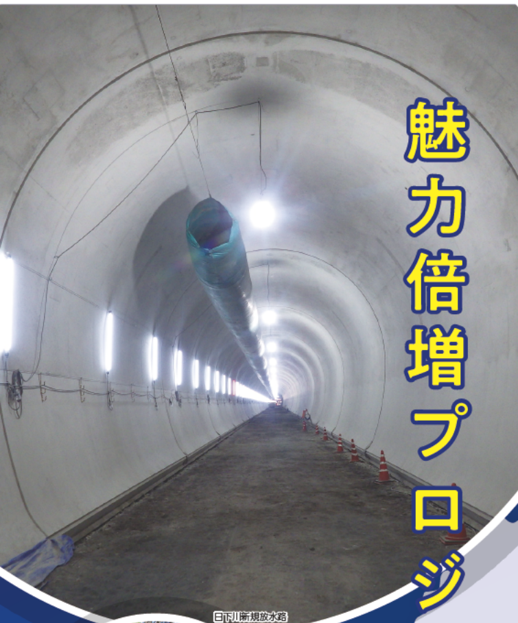
日下川新規放水路
